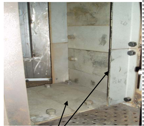
反射板取付け写真
